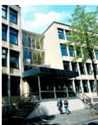
Rund 60 Appartements sollen im ehemaligen Arbeitsamt entstehen.
