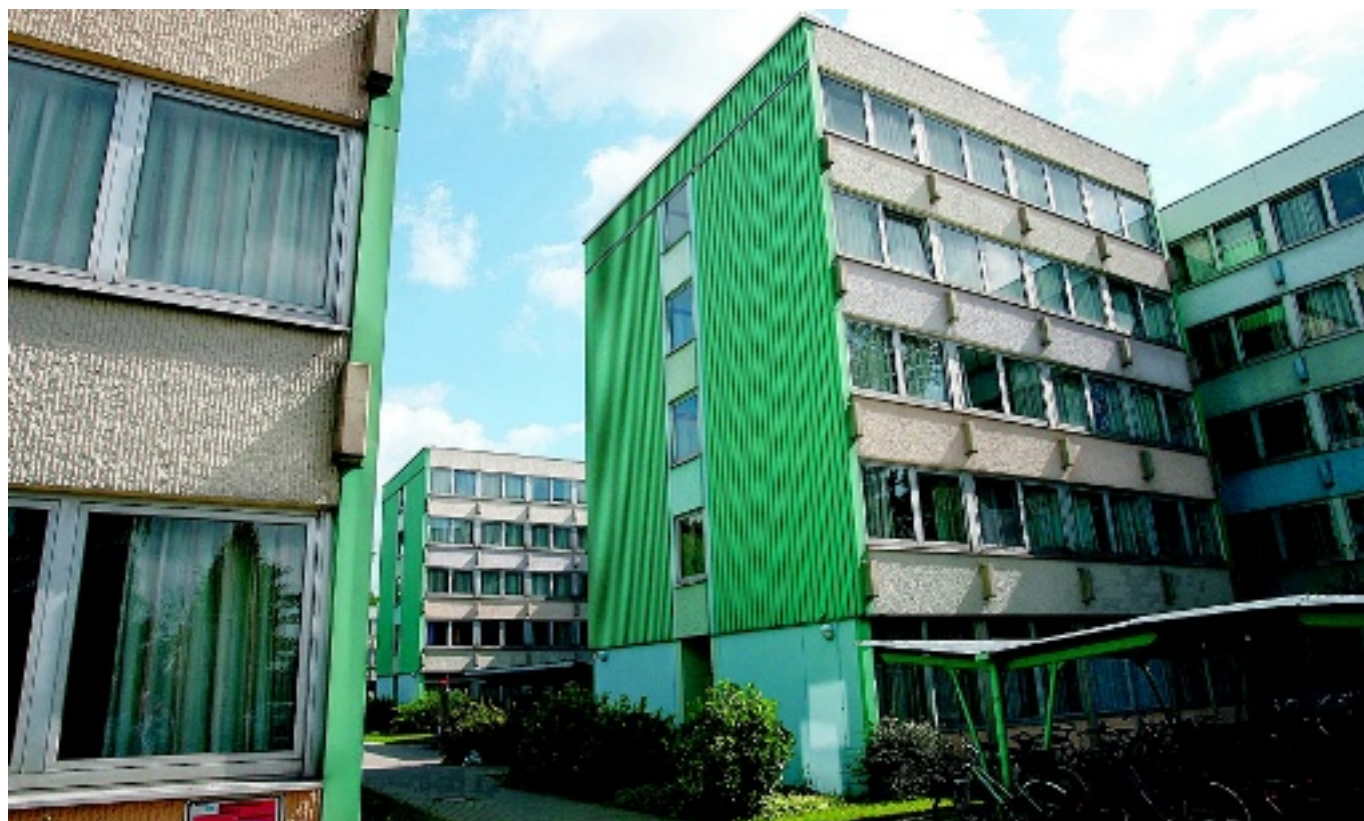
Renovierungsbedürftig: In den Wohnheimen am Horstmarer Landweg stehen 200 Zimmer leer.
